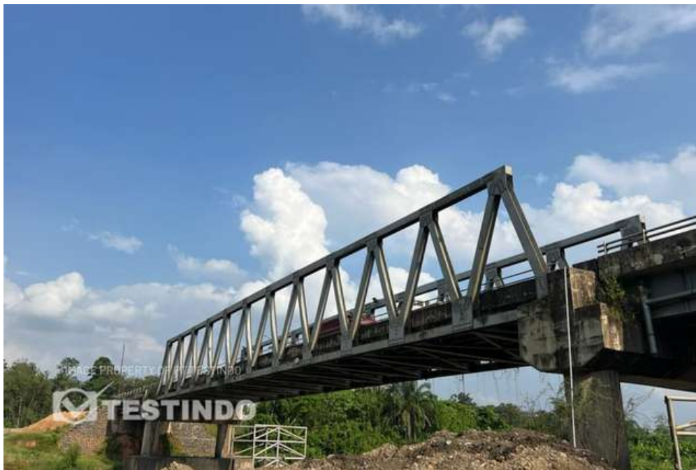
Assessment, Testing, Analisis Struktur dan Loading Test Jembatan Lematang PALEMBANG
