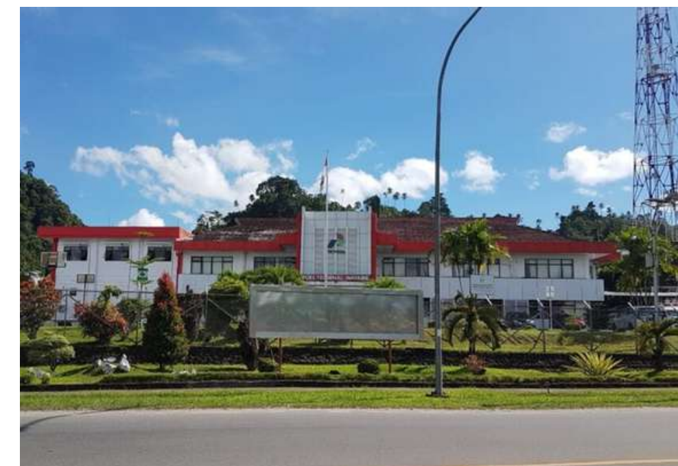
Assessment dan Testing Gedung PT Pertamina Patra Niaga Maluku PAPUA
