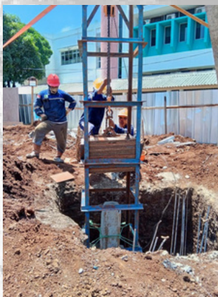
Pengujian PDA Test di Renovasi Gedung Badan Informasi Geospasial
