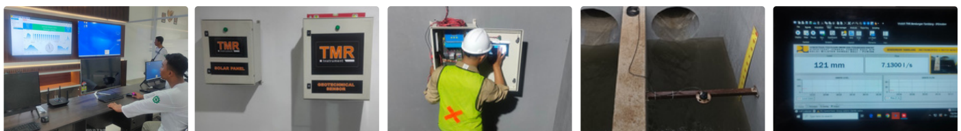
Instalasi AWLR di Bendungan Tamblang, Tahun 2023, Client: Kementerian PU - BWS SUNGAI BALI - PENIDA
