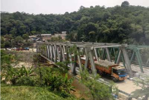
Loading Test Jembatan Grandong - Jawa Barat
