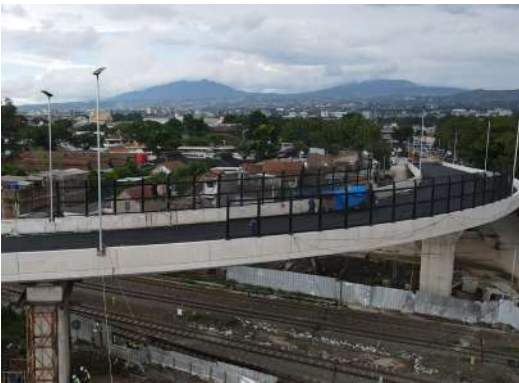
Loading Test Jembatan Ciroyom Bandung
