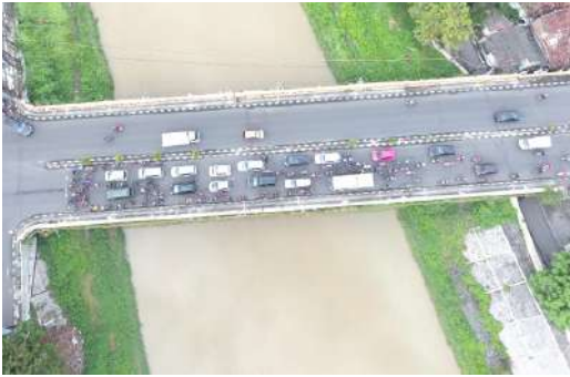
Loading Test Jembatan Kaligarang - Semarang
