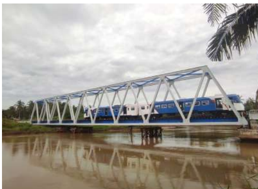
Loading Test Jembatan Kereta Api di Aceh
