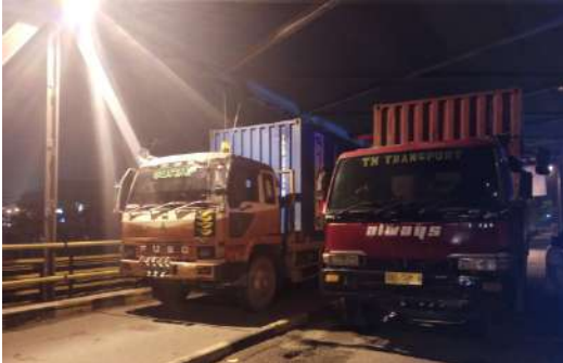
Loading Test Jembatan Tambarangan Banjarmasin
