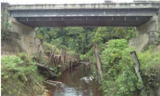
Loading Test Jembatan Bukaka
