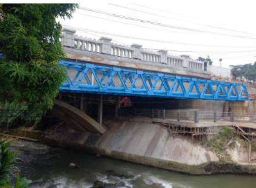
Loading Test Jembatan Otista - Bogor Jawa Barat
