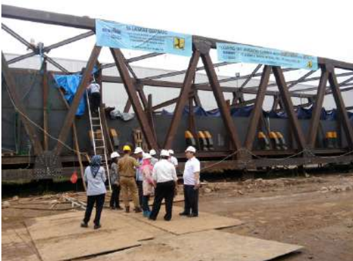
Loading Test Jembatan Rangka Baja 60M
