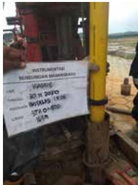
Instalasi Inclinator Bendungan Marangkayu
