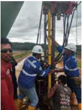
Instalasi Inclinator Bendungan Marangkayu
