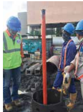
Instalasi Inclinator di Lombok
