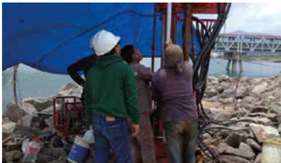
Pekerjaan Pengeboran Inclinator Lotte Merak
